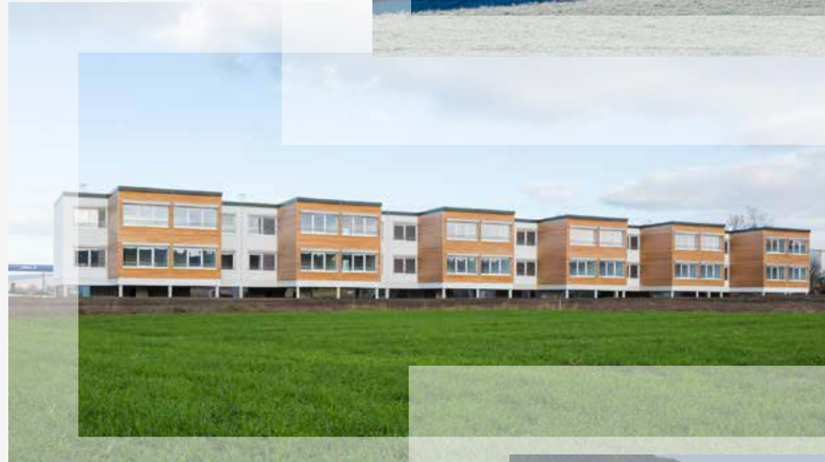
2013 Herzogenburg SG Neunkirchen Holzfertigteilbauweise
