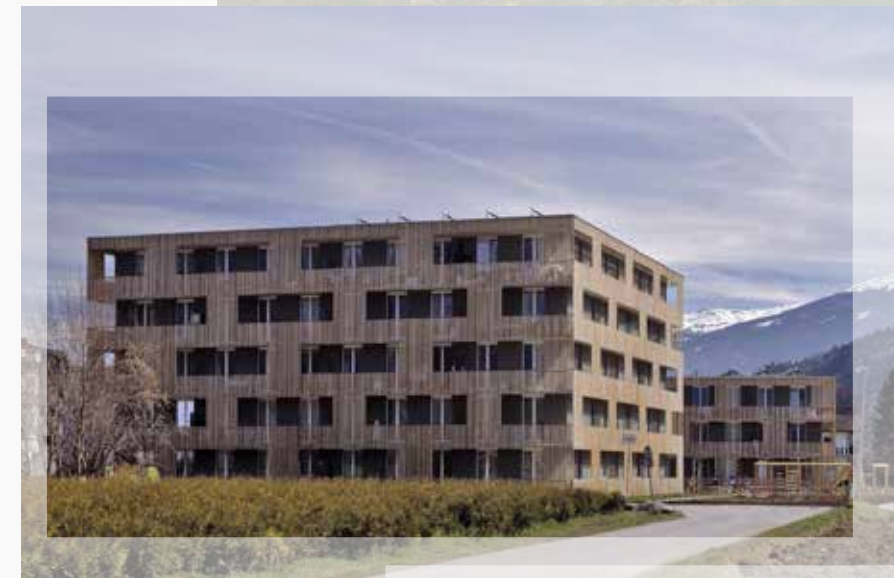
1997 Mitterweg 157-159, Innsbruck Neue Heimat Tirol Erstes mehrgeschossiges Energiesparhaus Tirols, Bauherrenpreis Tirol 1999
