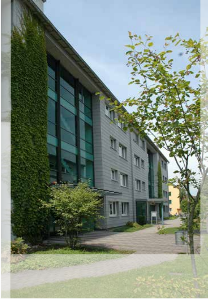
1996 Bachstraße, Bregenz Wohnbau- selbsthilfe
