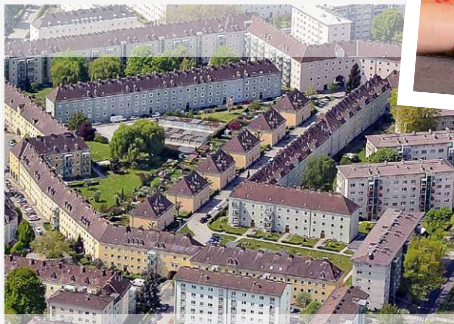
RIEGLSTRASSE Linz-Urfahr GWG
