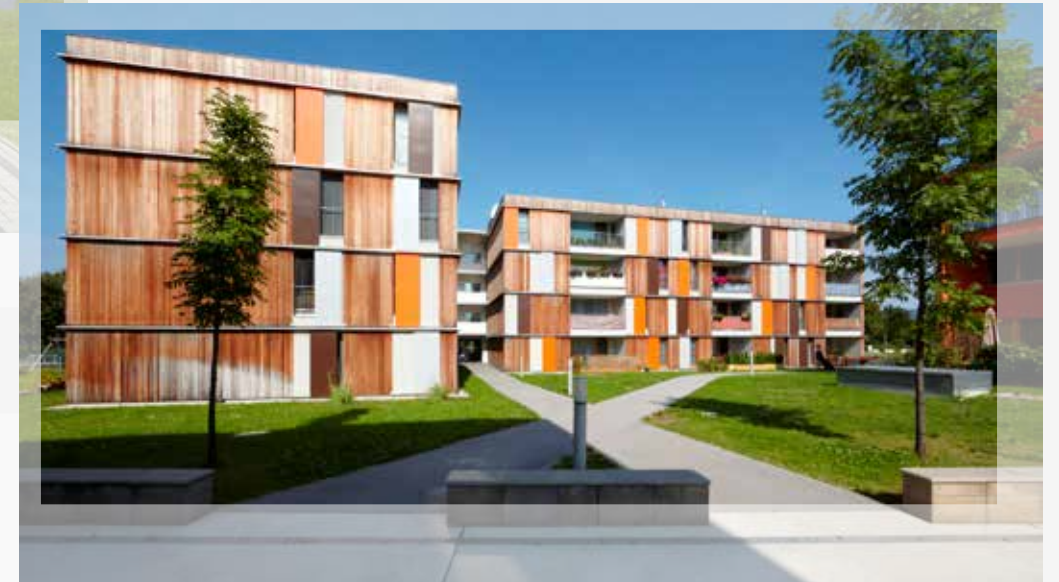
2006 Mühlweg / Fritz-Kandl-Gasse, Wien - Floridsdorf BWSC Bauträgerwettbewerb „Holz im Wohnbau“
