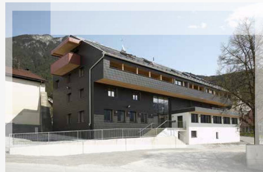
2008 Gemeindehaus Karrösten Alpenländische Heimstätte Umbau eines Gebäudes aus den 60ern auf Passivstandard
