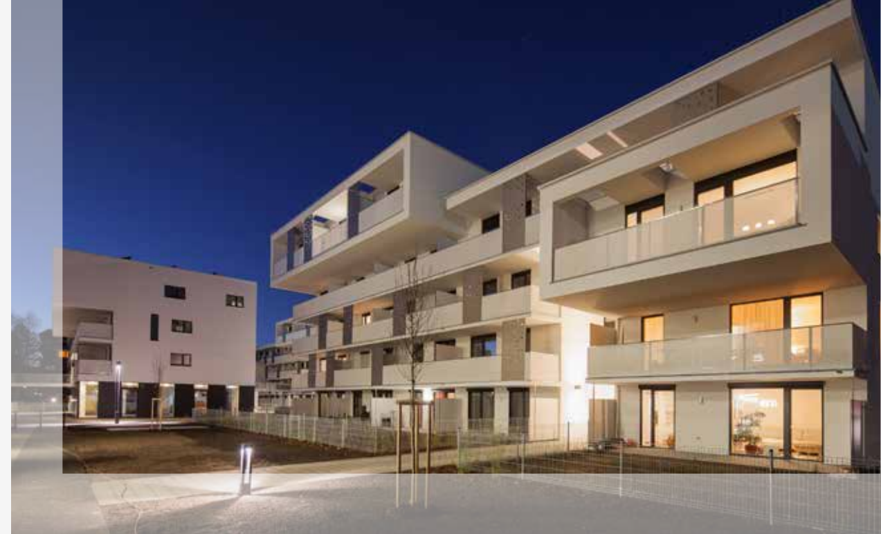
2013 „Rosa Zukunft“, Rosa-Hofmann-Straße, Salzburg Salzburg Wohnbau, Die Salzburg Generationenübergreifendes Wohnen
