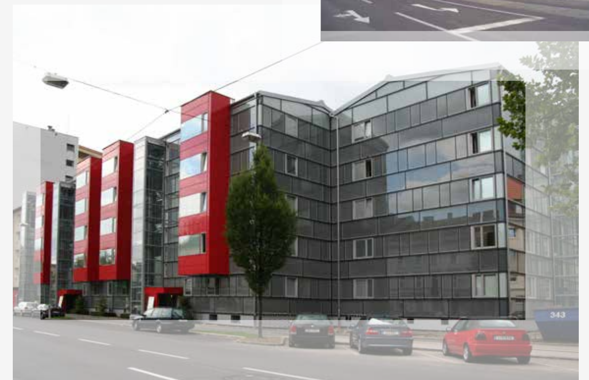
1958, san. 2006 Makartstraße, Linz Giwog Sanierung auf Passivhausstandard, Staatspreis 2006 für Architektur und Nachhaltigkeit
