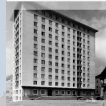
1957, san. 2014, Fassadengestaltung 2015 Wiener Straße 56-58, Kapfenberg Wohnbauvereinigung für Privatangestellte
